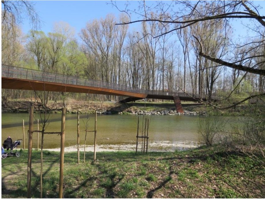
Der Isarsteg in Freising
