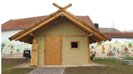
Das fertiggestellte Keltenhaus in Bruckberg
